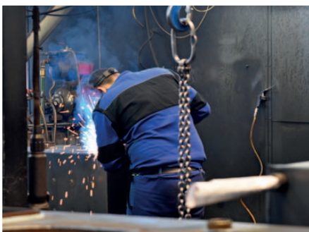
Ruční svařování kotlů
