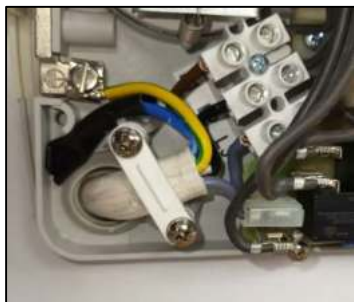
Příklad zapojení 3 x 400 V
